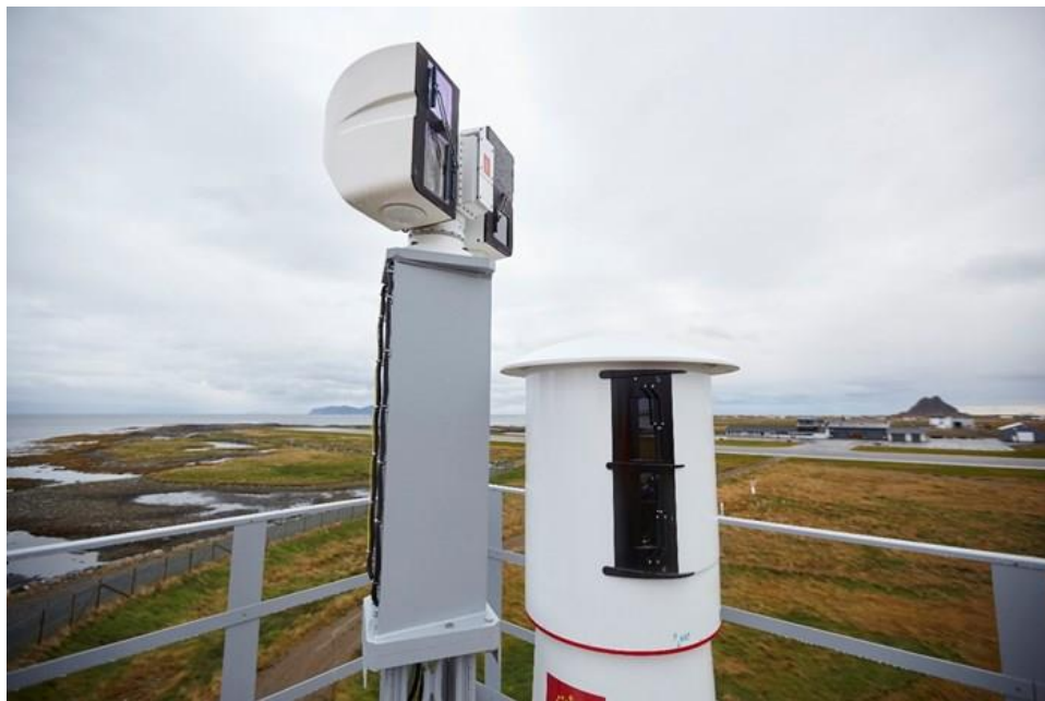
Figur 6: Fjernstyrt flytårn (Kilde: Avinor)
