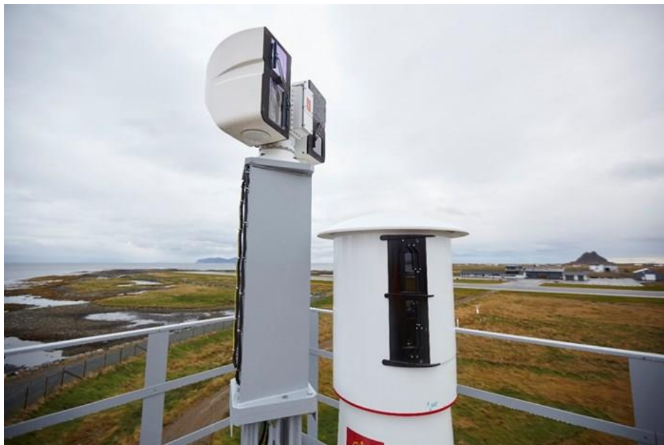
Figur 6: Fjernstyrt flytårn (Kilde: Avinor)
