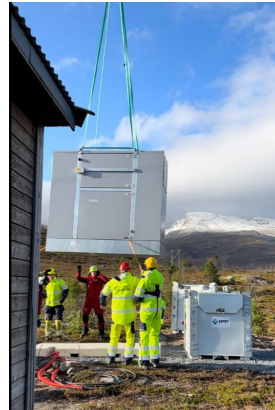
Arbeid på basestasjon med etablering av forsterket ekom (foto: Nkom)
