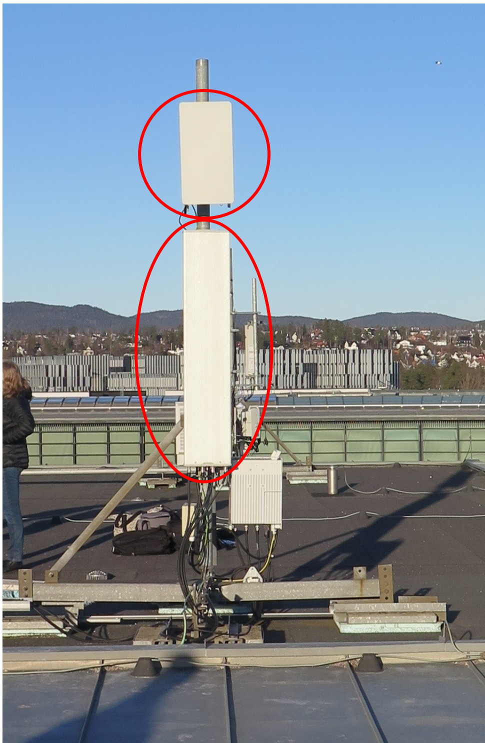
Figur 4 Sektor nr. 2 på basestasjonen, 26 GHz øverst og 3,6 GHz nederst
