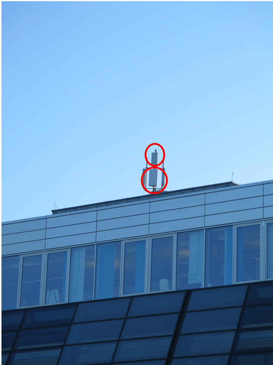
Figur 3 Sektor nr. 1 på basestasjonen, 26 GHz øverst og 3,6 GHz nederst
