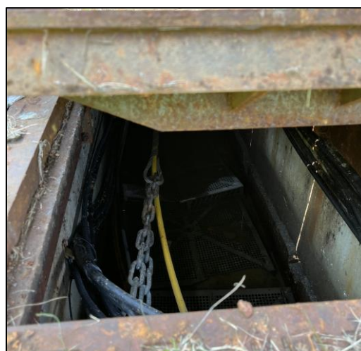
Figur 15: Sjøfibernkabel festet med kjetting nede i kum
