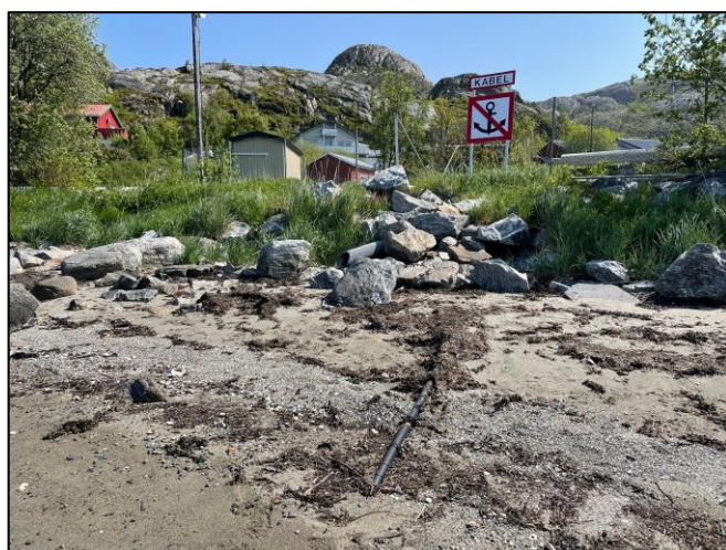
Figur 14: Et av landtakene langs Trøndelagskysten. Fibernkabel ligger delvis åpen i strandsonen
